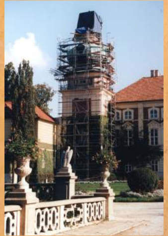
Remont hełmu na wieży. 2003 r.
