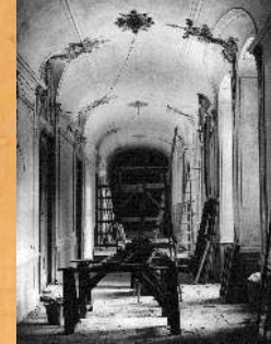
Korytarz Biały w trakcie konserwacji. 1969 r.
