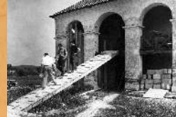
Remont Spichlerza - magazynu muzealnego w Brzózce. 1968 r.
